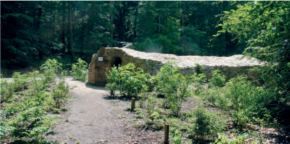
Abb. 4 Die Zauberhöhle vor und nach der gartendenkmalpflegerischen Instandsetzung (Foto: Oana Szekely (oben), Inken Formann (unten))
